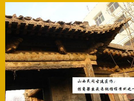
图2-0-28晋中某宅门抹角梁出头照片
