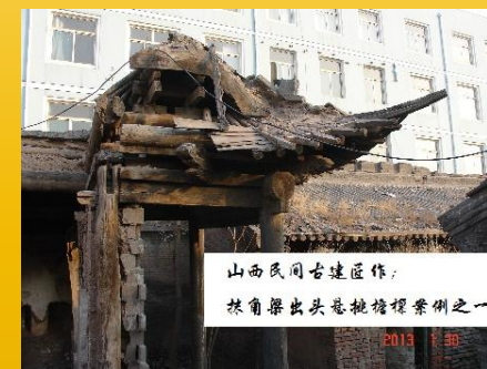
图2-0-27晋中老民居抹角梁出头照片
