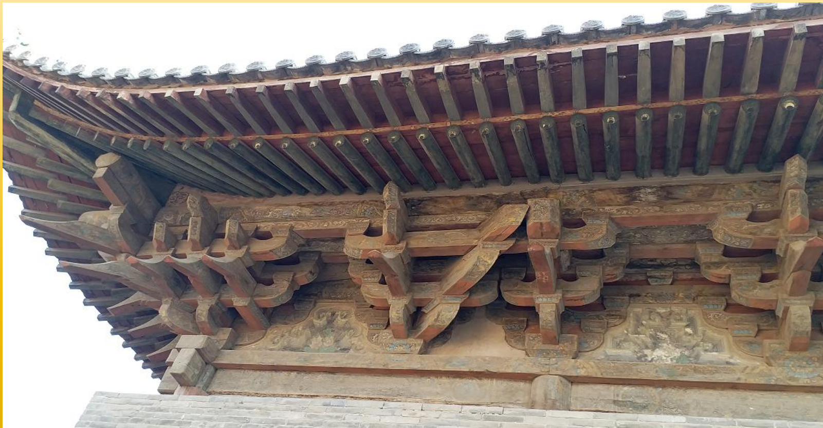
图2-0-25晋中城隍庙抹角梁出头照片
