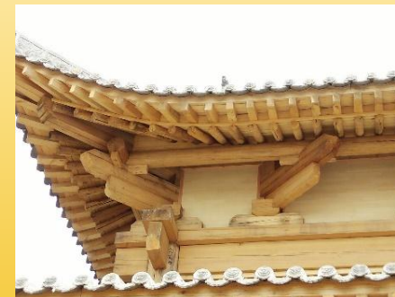
图2-0-26原平大成殿抹角梁出头照片
